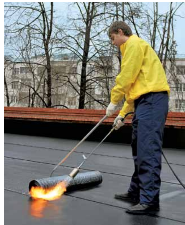
4 pav. Stogdengio padėtis dengiant stogą
