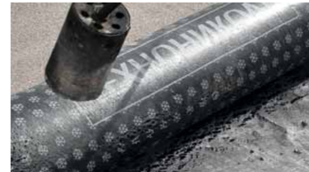
5 pav. Piešinio deformacija apatinėje ritinio pusėje, teisingai kaitinant paviršių
