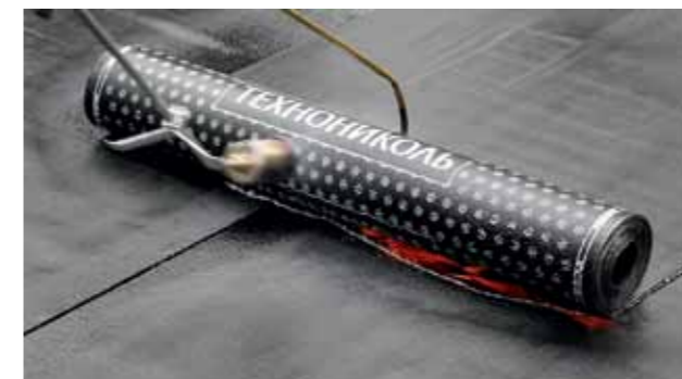
6 pav. Iššildytos polimerinės – bituminės masės „banga“
